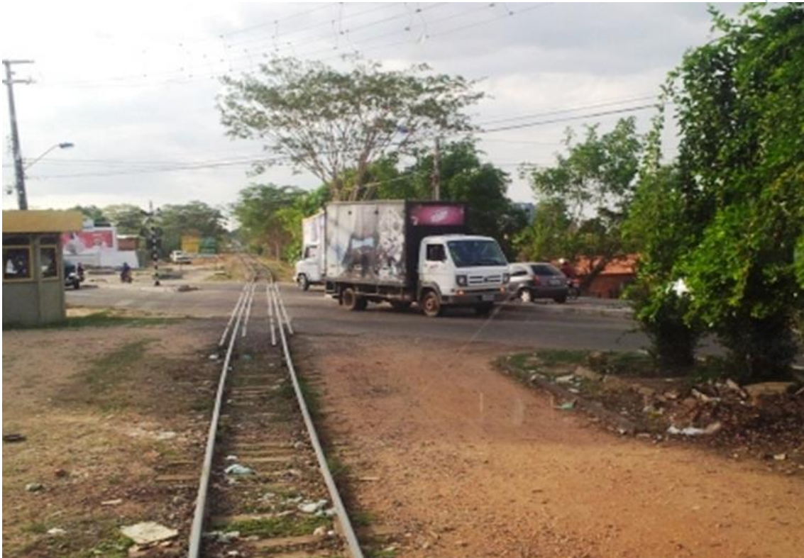
Passagem em Nível – Av. Higino Cunha – Local de acidentes Companhia Ferroviária e de Logística do Piauí Av. Miguel Rosa, 2885, Cabral Teresina-PI, 64000-512
