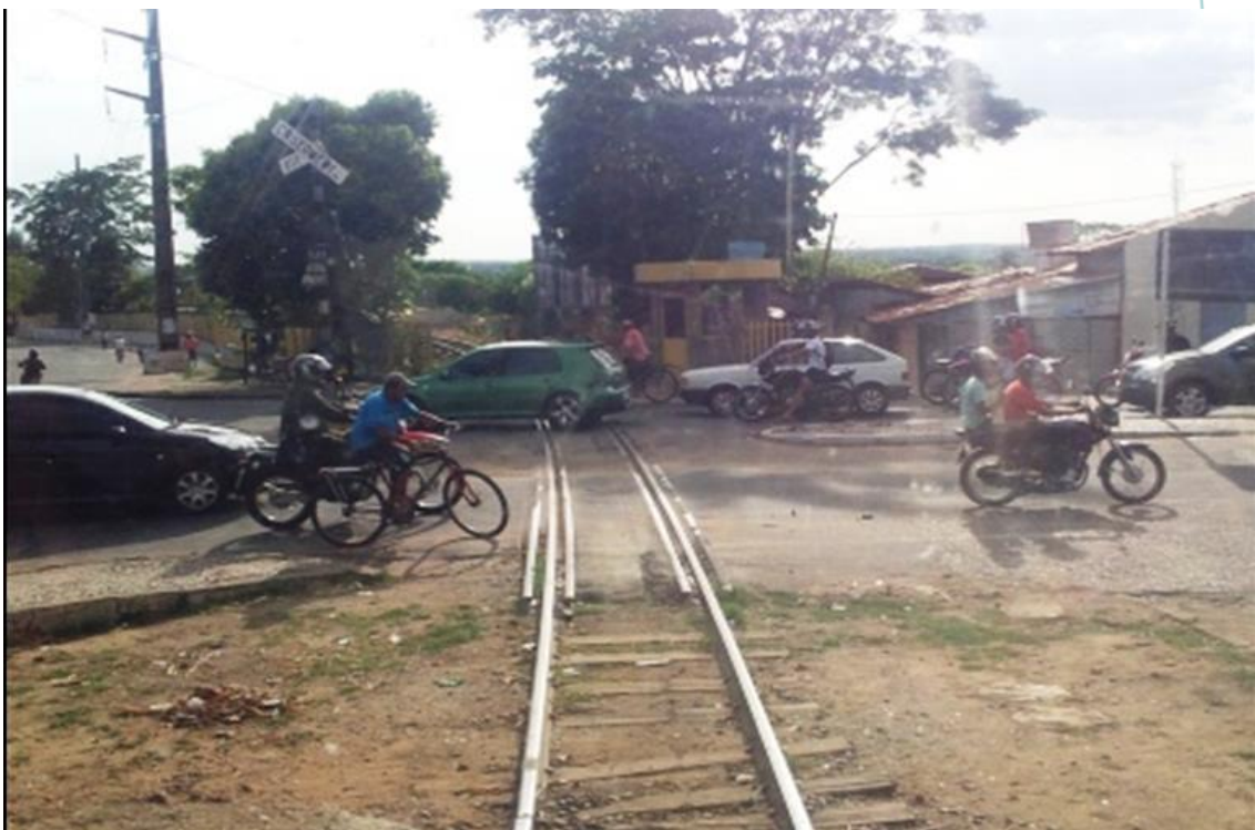
Passagem em Nível – Av. Rui Barbosa
