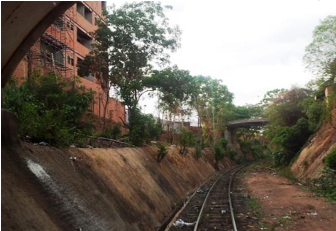
Viaduto São Pedro
